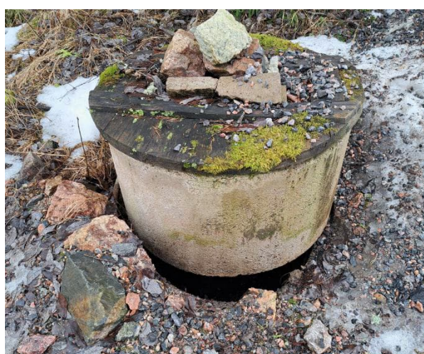
6. Vanha kaivo metsän reunassa
